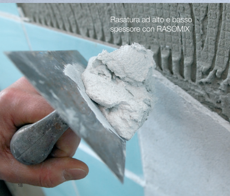
Rasatura fresco su fresco su intonaco nuovo con RASANTE 2000 2K
