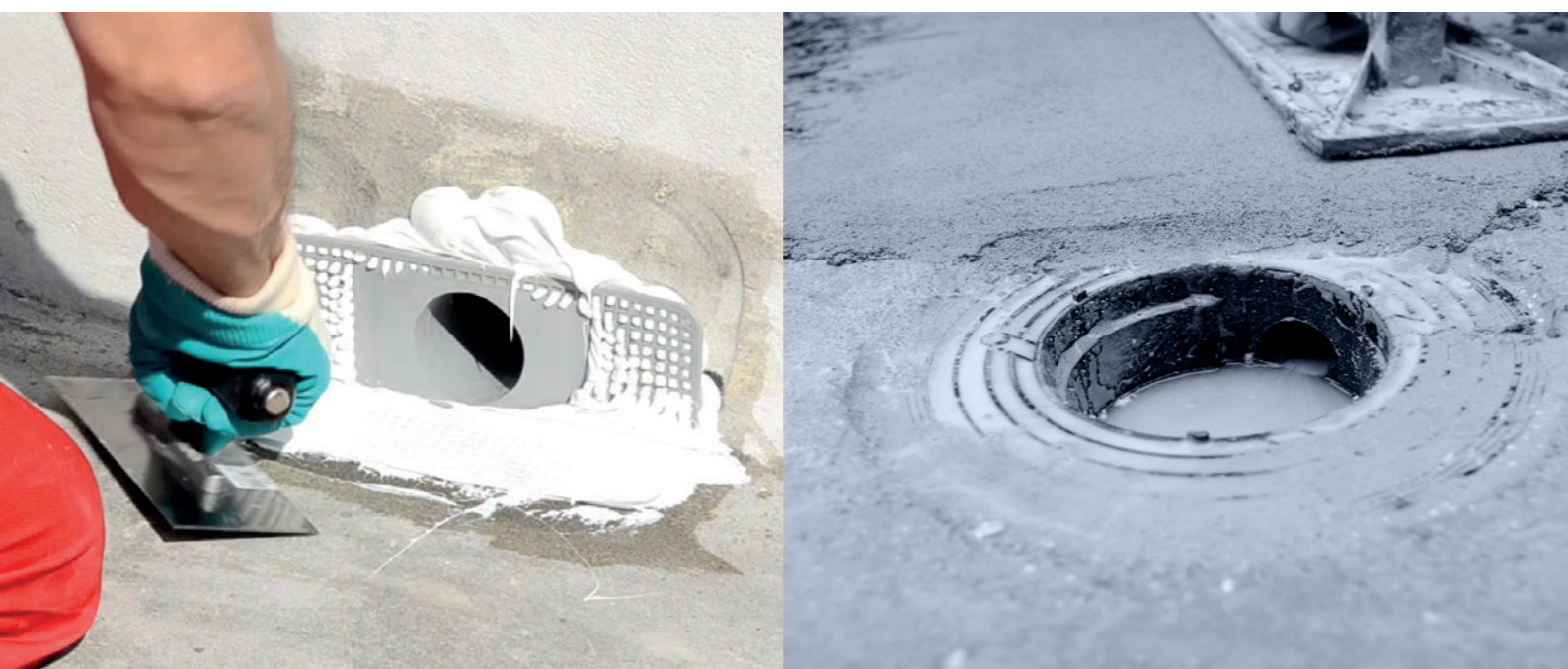
SOSTITUZIONE DI SCARICHI A PAVIMENTO
