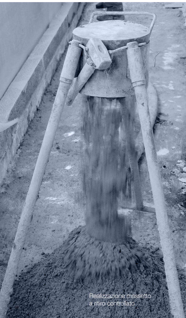
Realizzazione massetto con SC1 BASE
