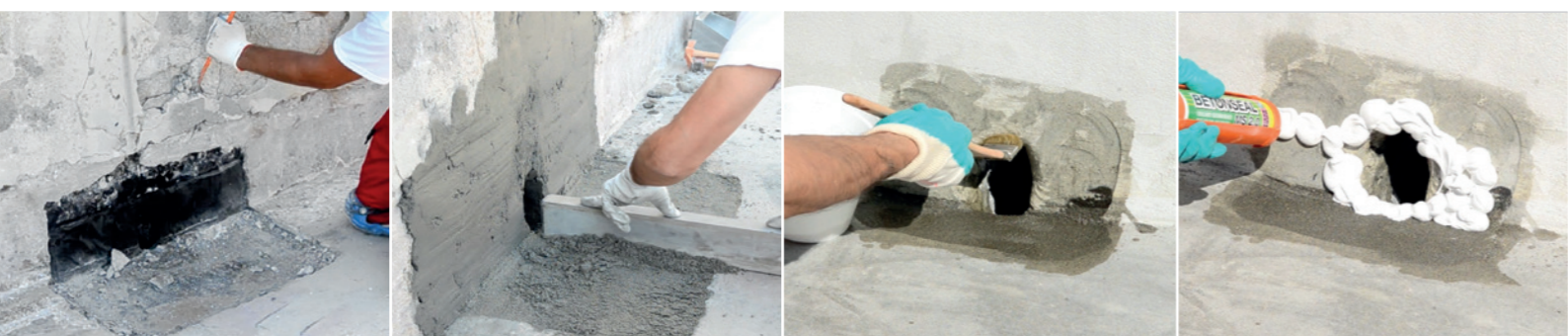
Demolizione dello scarico esistente
