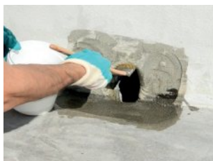
Gruntowanie przy użyciu Norphen Fondo Igro
