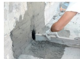
Rekonstrukcja przy użyciu MALTAFIX lub NORDGROUTH TIXO
