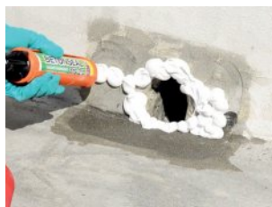
Montaż odpływu przy użyciu BETONSEAL MS 2.0
