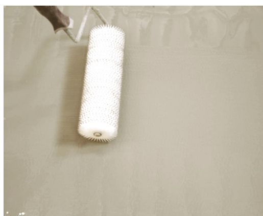
Figura 4 - Utilizzo del frangibolle sulla seconda mano.
