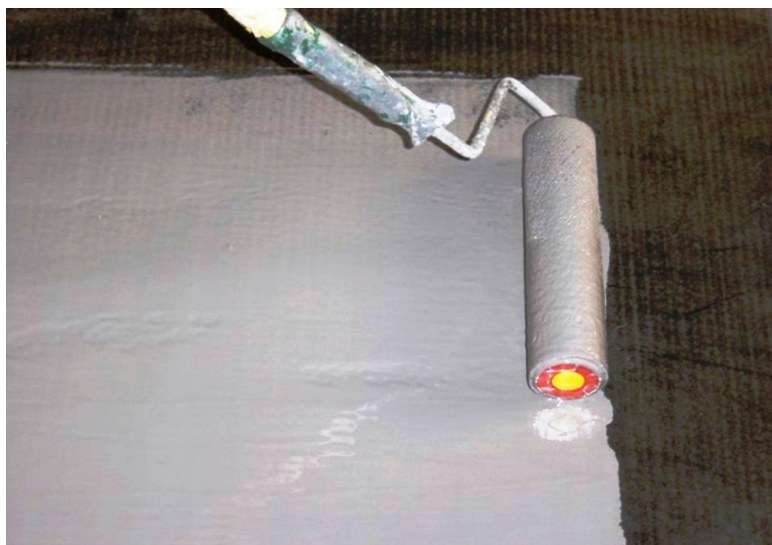
Figura 1 - Applicazione a rullo su guaina bituminosa.
