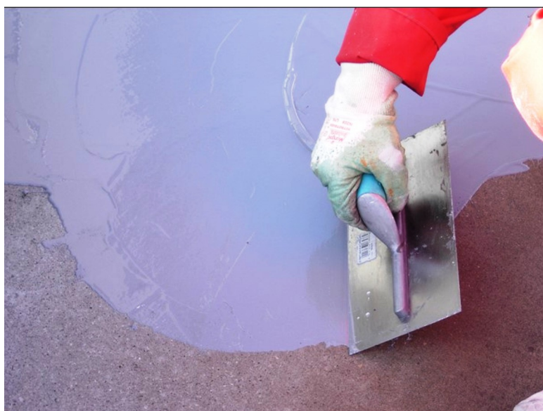
Figura 2 - Rasatura su calcestruzzo.
