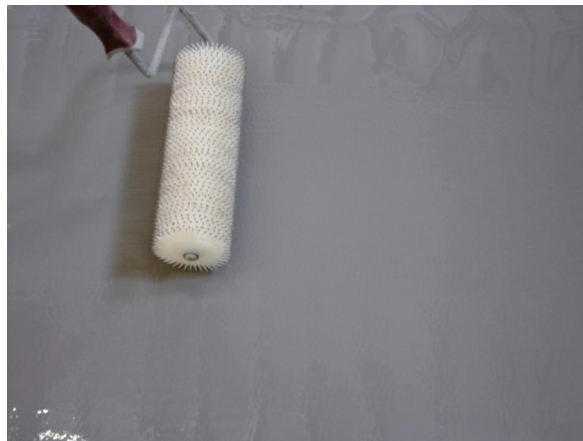
Figura 4 - Utilizzo del frangibolle sulla seconda mano.
