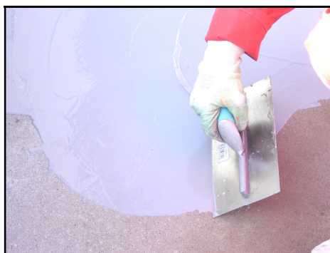
Rys 2 – Zacieranie na betonie
