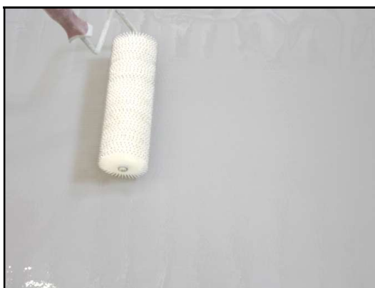
Rys 4 – Zastosowanie wałka do odpowietrzania w drugiej warstwie.
